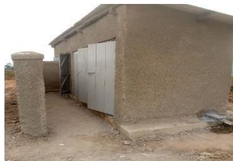
ドアが取り付けられたトイレ
