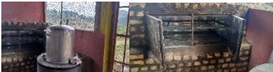
蒸し器、薪オープン（建設中）
