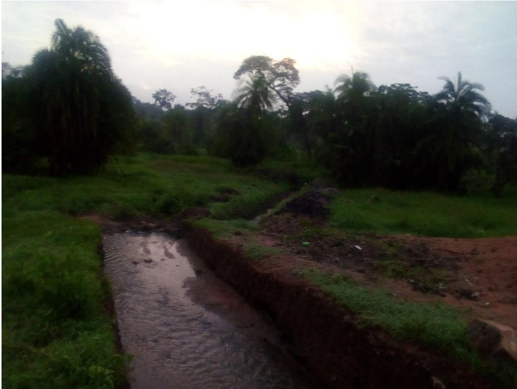
ナビンゴラ準郡 Kiyita 村の湿地に土地開拓を目的とした排水路の建設
