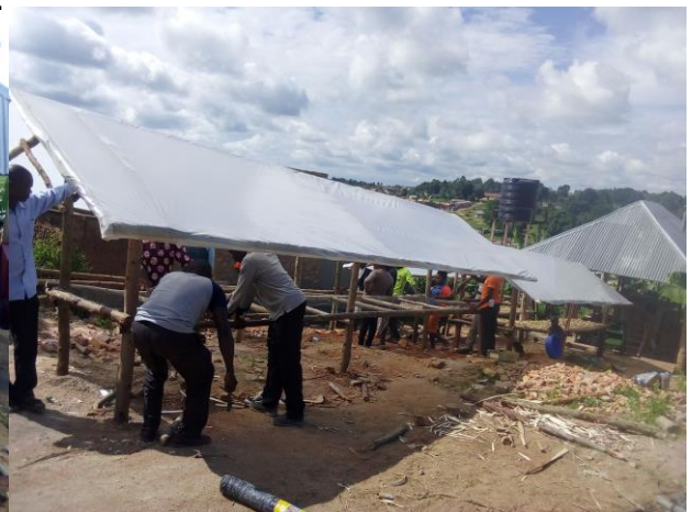
ブリケット炭乾燥場の組み立て。
