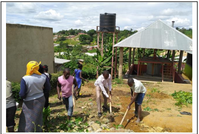
レモンオイル工場近くに、乾燥場の建設地を準備。
