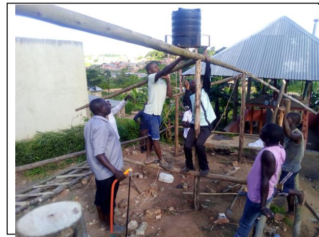
乾燥機の組み立て。
