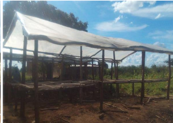
日よけシートを設置。
