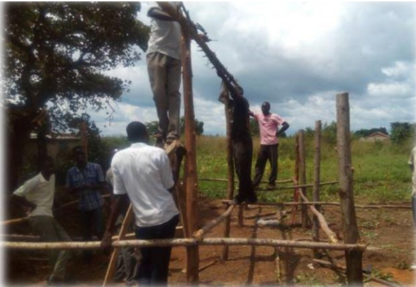
乾燥機の日よけを組み立てる。
