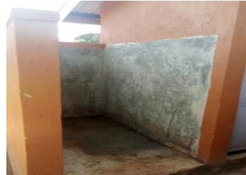
ドアと屋根の取り付けが必要 (Ssanga C/U 小学校)
