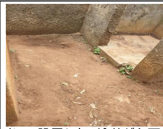
ドアの設置と床の塗装が必要な洗面所 (Bule 小学校)
