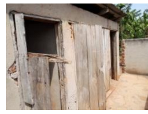
ドアと床の補修が必要な女子トイレ (Kitanda Church of Uganda 小学校)
