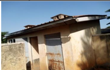
水をタンクまで運ぶための桶、及び水道を2か所取り付ける必要がある。
