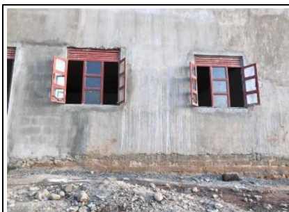
ドア及び窓を取り付けた。
