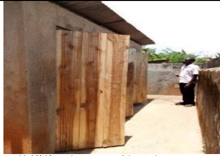
<修繕後> ドアを取り付けたトイレ
