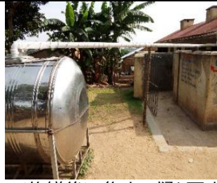
<修繕後> 集水の樋と雨水浸透ますを修繕した。
