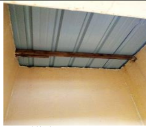
<修繕後> 鉄製シートを取り付けた。
