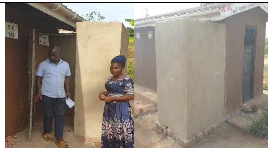
<修繕後> 更衣室を拡大し、ドアに鍵を取り付けた。
