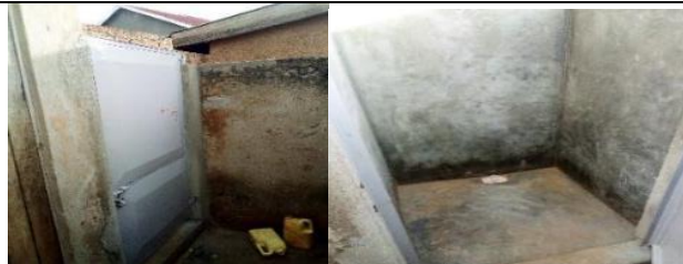
<修繕後> 粗い状態であった洗面所の壁の修繕に加え、新たにドアを取り付けた。
