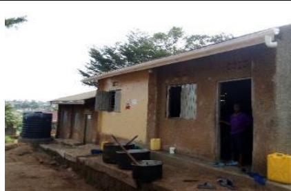
<修繕後> 水タンクには集水の樋がなかったが、樋を取り付け雨水が貯まるようにした。
