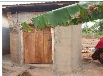
<修繕後> 更衣室がなかったため新たに設置し、ドアと屋根を取り付け、漆喰を塗った。
