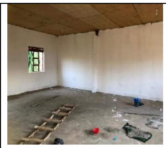
壁の工事が進んでいる。
