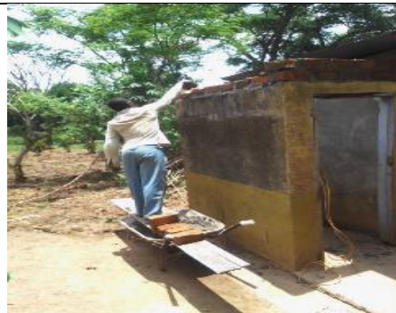
<修繕後> 修繕作業中の女子用洗面所。ドアを取り付け、状態のよくなかった床や壁を修繕した。
