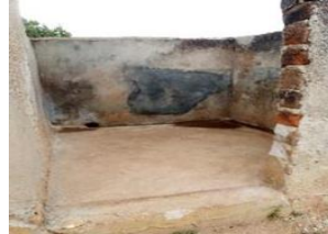
<修繕後> 女子用洗面所の壁の穴を埋め、覆った。
