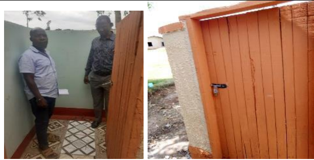
<修繕後> タイルを敷き、女子用洗面所にドアを設置した。
