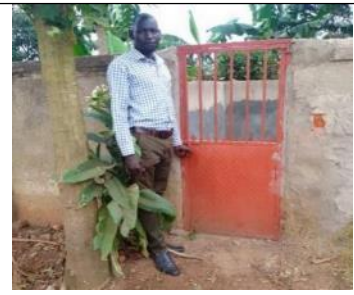
屋根はないがドアを取り付けた洗面所 (Nkokoma 初等学校)
